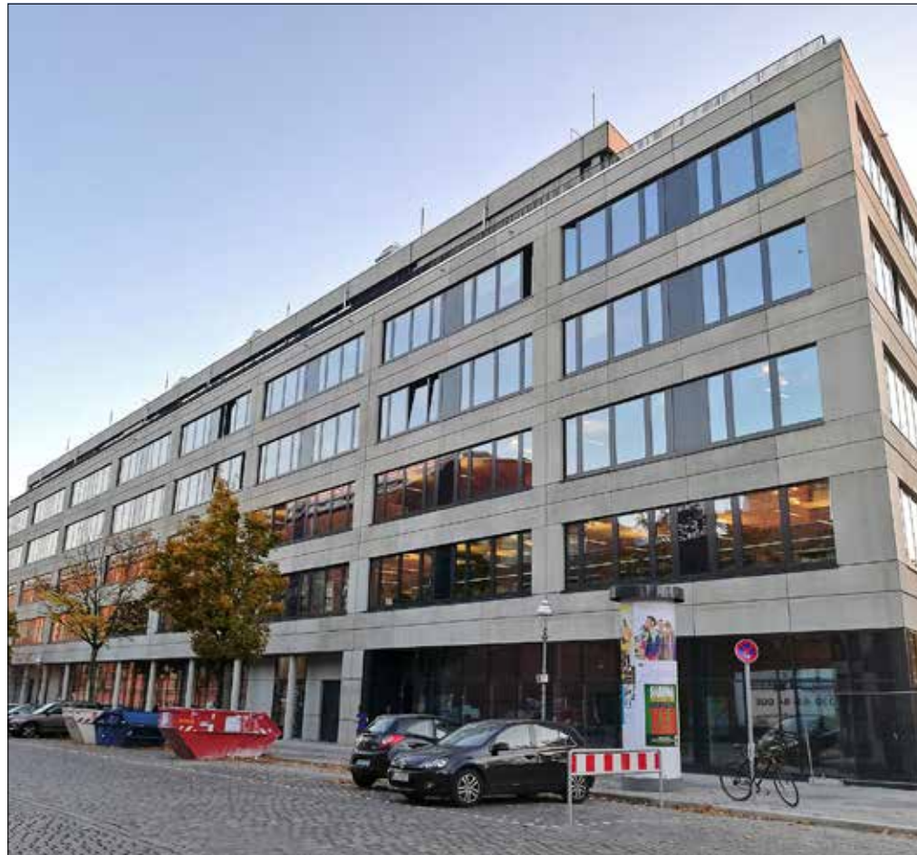
Das erste Projekt von Townscape in der Hussitenstraße ist bereits fertig.
