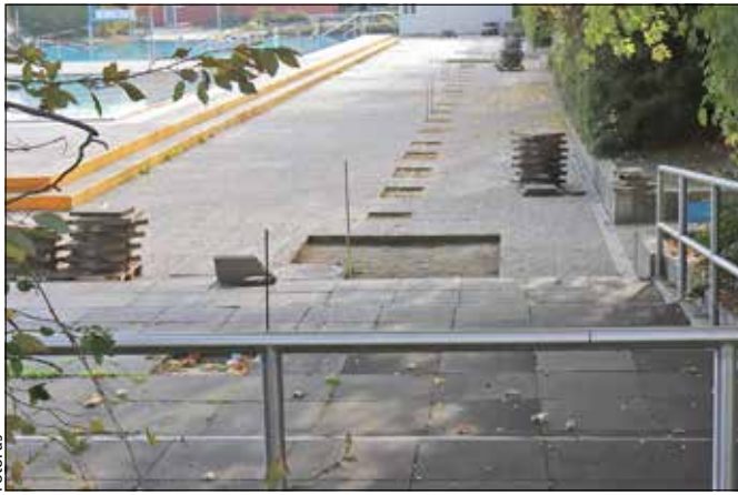
Die ersten Spatenstiche für die Traglufthalle sind gemacht.
