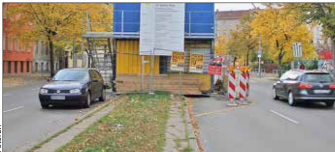
Baustelle in der Schulstraße: U-Bahnhof Nauener Platz wird umgebaut.
