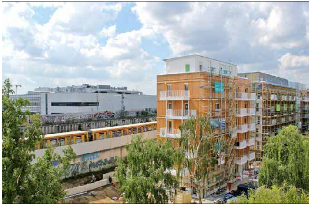
Das Holzhaus in der Lynarstraße kurz vor Fertigstellung. Die Ringbahn fährt direkt hinter dem Haus. Foto: dh
