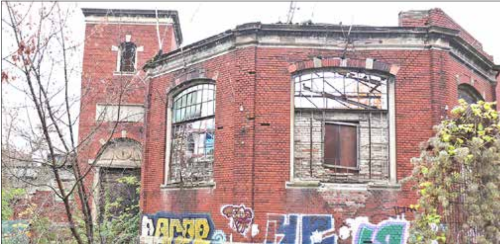
Das 1896 gebaute Gebäude muss dringend saniert werden. Der Bund hilft jetzt dabei.
