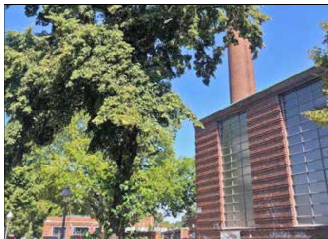
Der Turm gehört zu einer früheren Umformstation.
