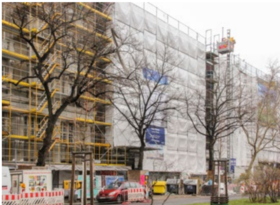
Noch sieht man dem „Roxy“ den Sanierungsstatus an
