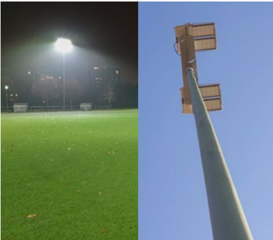
An der Sportanlage Vorarlberger Damm 33 erstrahlt der Platz unter LED-Leuchten
