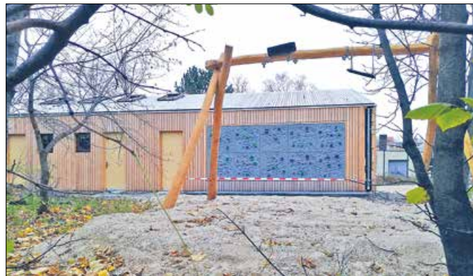
Noch mit Absperrband, aber trotzdem fast fertig sind die neuen Häuser auf dem Abenteuerspielplatz Telux. Foto: dh
