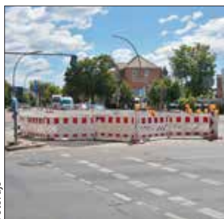
Die Baustelle am Oraniendamm
