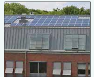
Strom vom Dach
