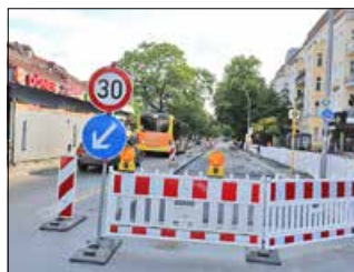
Sanierung der Seestraße
