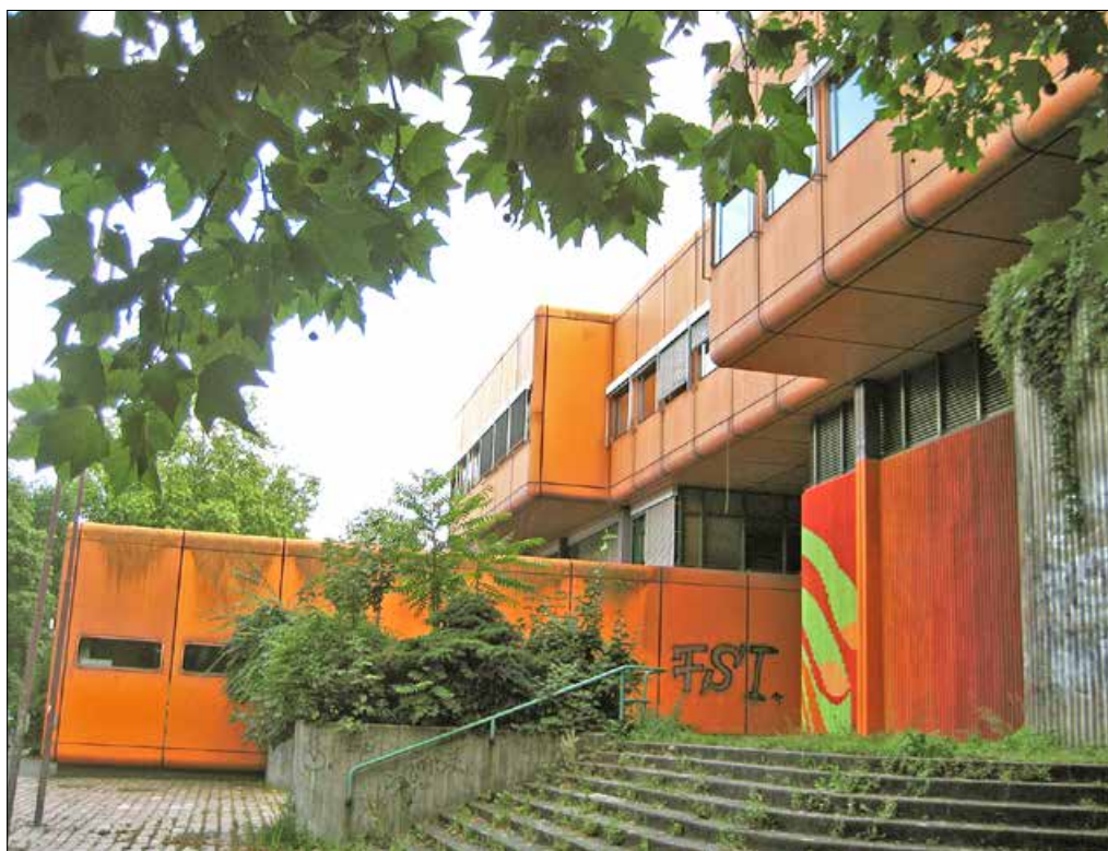
Besonderes Denkmalkonzept für ungewöhnlichen Schulbau
