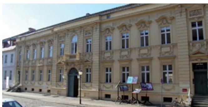
Gebäude des Nikolaisaals
