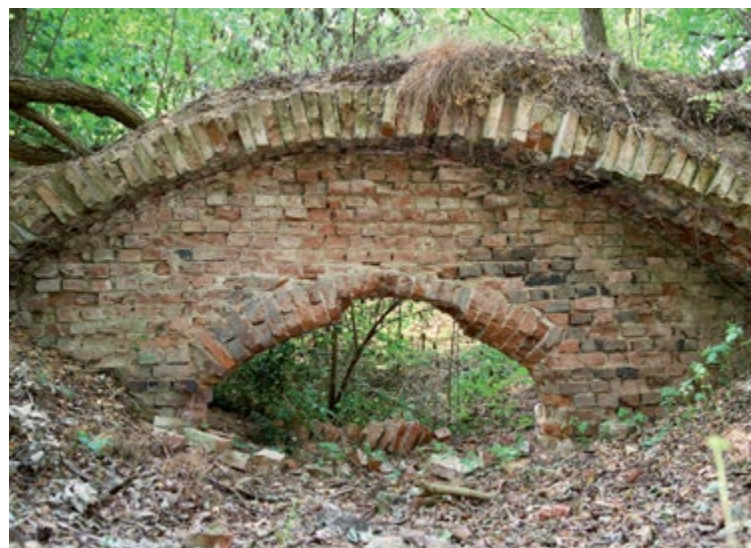
Die Spuren des mittelalterlichen Weinkellers im Wald unweit des Weinbergs.
