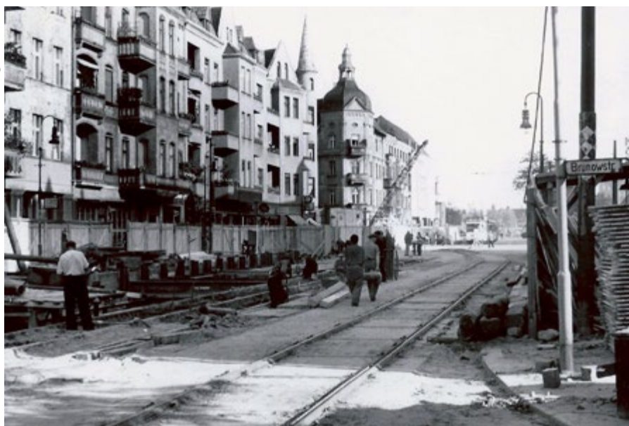
U-Bahn Bau Berliner Ecke Brunowstraße im Jahr 1957. Zu dieser Zeit fuhr die Straßenbahn trotz der Bauphase weiter.
