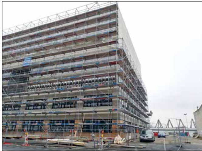
Noch im Rohbau: die Sporthalle der 48. Grundschule
