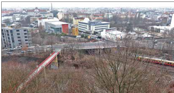
Der Express-Radweg Panke-Trail braucht eine neue Brücke über die S-Bahn. Foto: as
