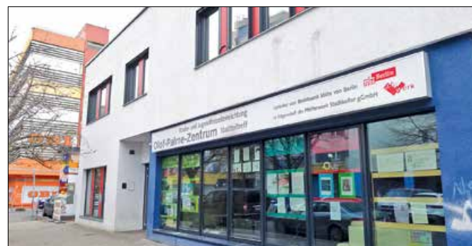
In der oberen Etage des Olof-Palme-Zentrums haben die Stadtteilkordinatoren des Gebiets Brunnenstraße Nord ihren Sitz. Foto: dh
