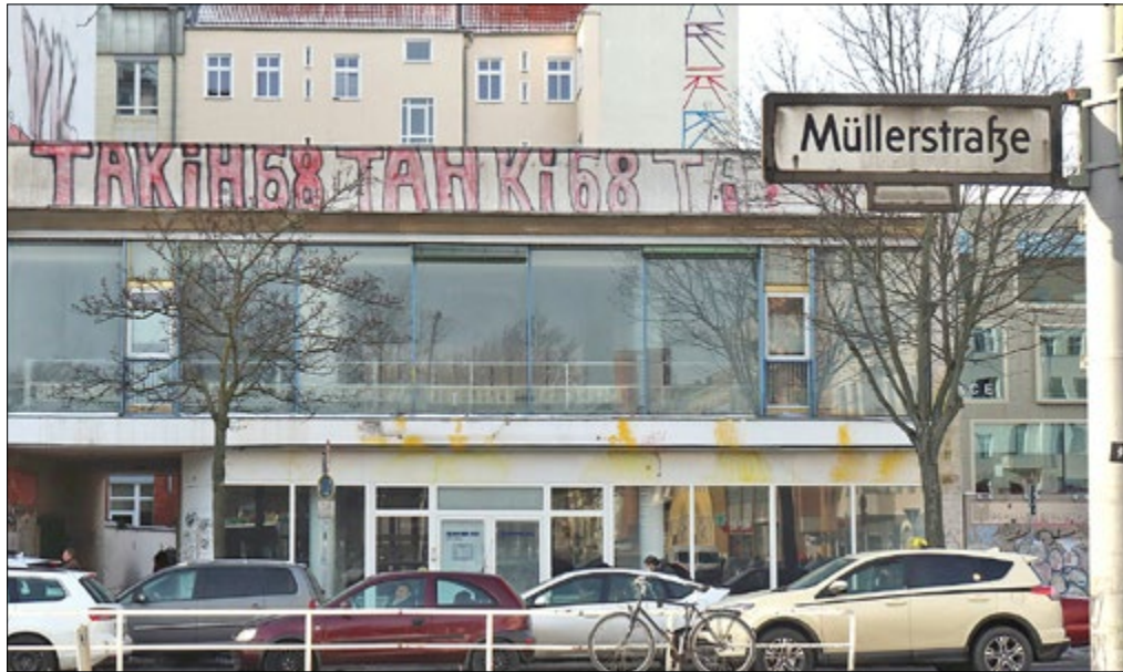
Die leerstehende ehemalige İsbank könnte Haus der Hilfe werden.
