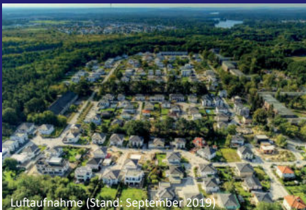
Luftaufnahme (Stand: September 2019)
