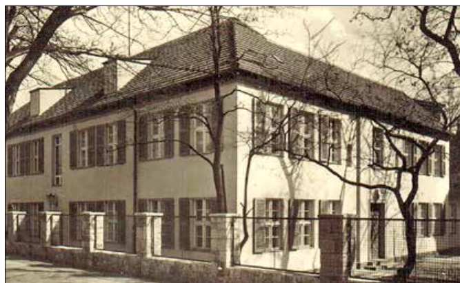
Das alte Schulhaus in der Schulstraße
