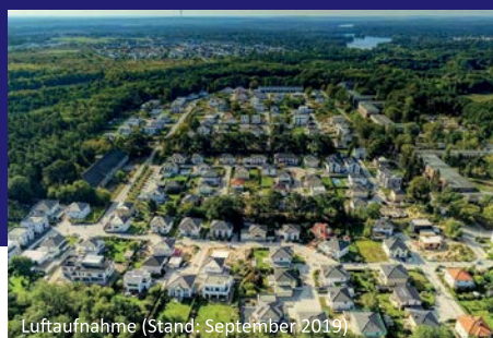
Luftaufnahme (Stand: September 2019)
