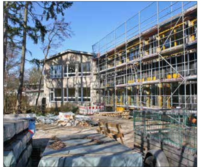
Bauarbeiten an der Alfred-Brehm-Grundschule
