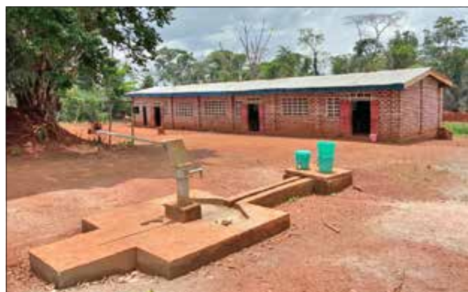
Der neue Brunnen auf dem Gelände der Grundschule Fotos (2): Bagandou e.V.
