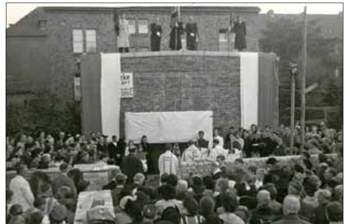
Am 14. Oktober 1951 wurde der Grundstein zur Kirche St. Rita gelegt. Auf dem Bild erkennt man im Hintergrund das Augustinerkloster an der Zobelitzstraße, das heute noch dort existiert und von drei Augustinerpatres bewohnt wird.
