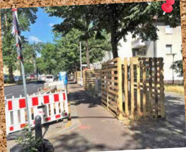
Bäume hinter Gittern (aber aus Holz): Entlang der Scharnweberstraße sind in nördlicher Richtung seit einigen Wochen etliche Straßenbäume eingezäunt. Grund sind Rohrarbeiten. Foto: bek
