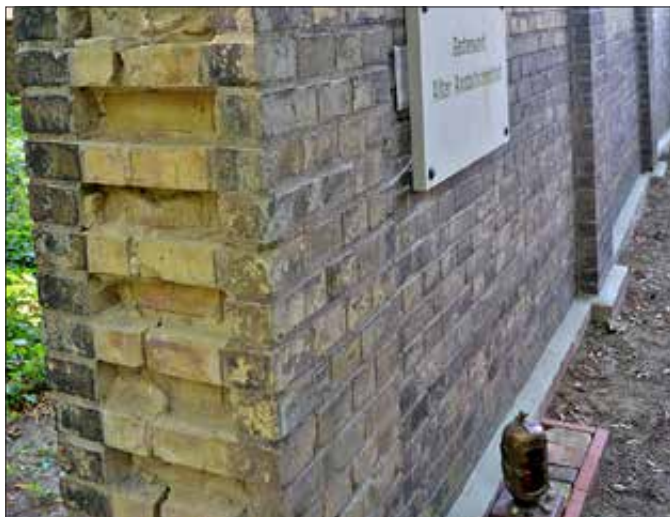
Nur die Friedhofsmauer und die Anfang des Jahres montierte Gedenkplakette erinnern an den ehemaligen Anstaltsfriedhof.
