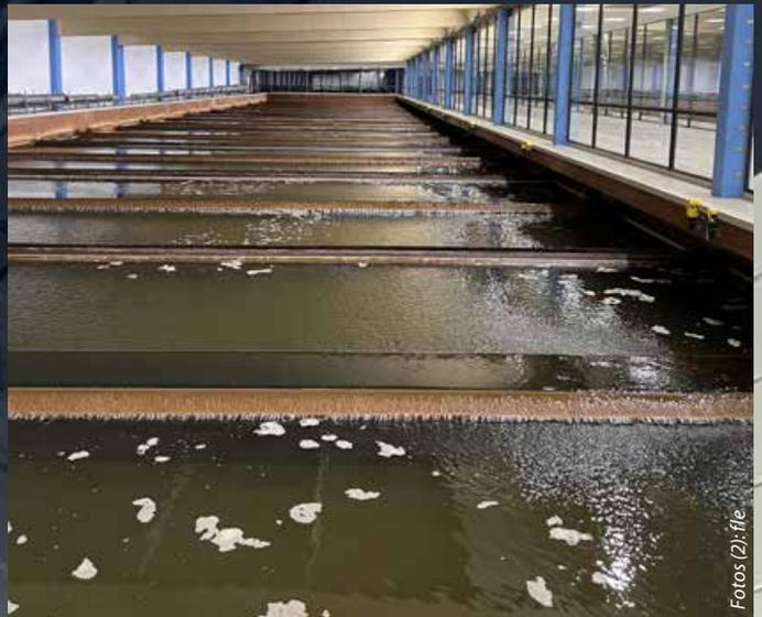
*In den Doppelschnellfiltern werden Mangan und Eisen herausgefiltert.*
