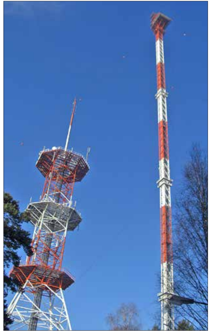
Stahlfachwerkurm und der gesprengte Gittermast
