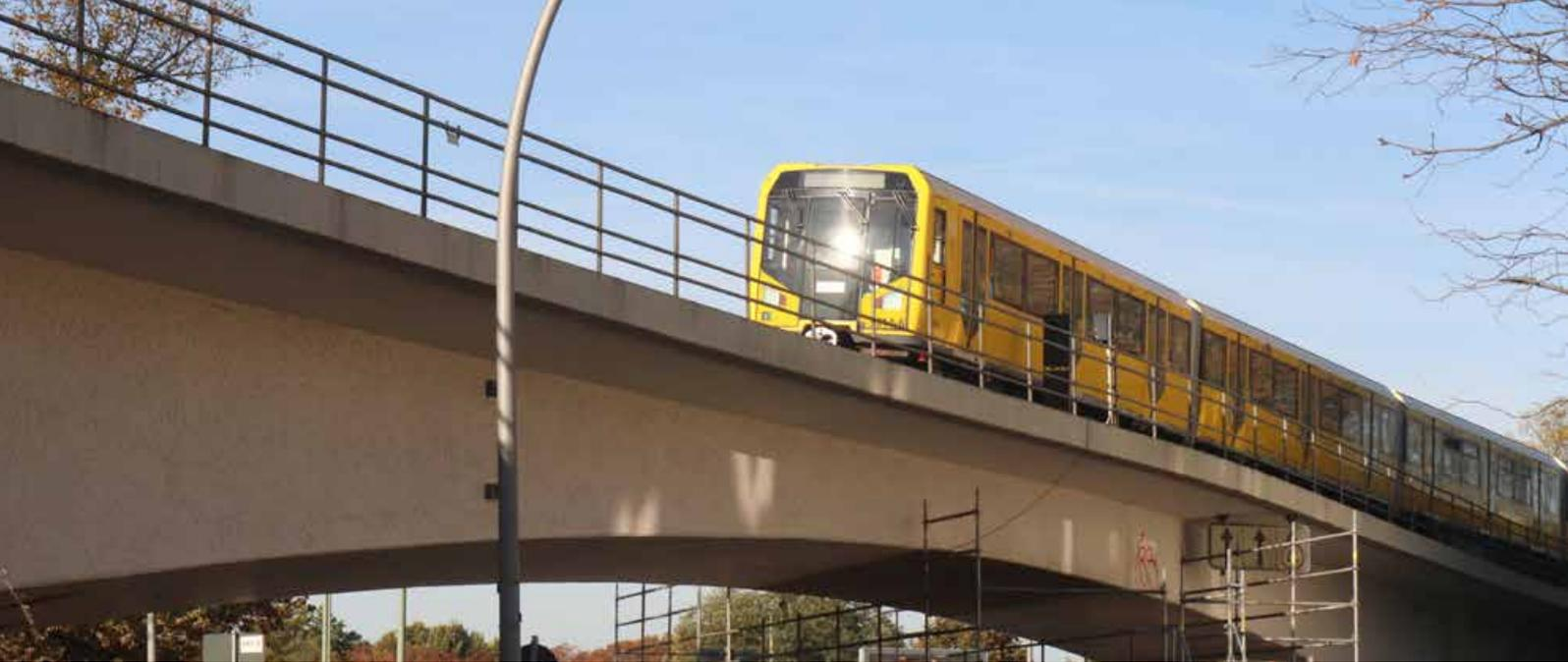
Die Seidelbrücke, eine Spannbetonbrücke, wird abgerissen und durch einen Neubau ersetzt.
