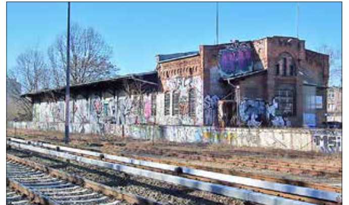
Der Güterschuppen an der Roedernallee
