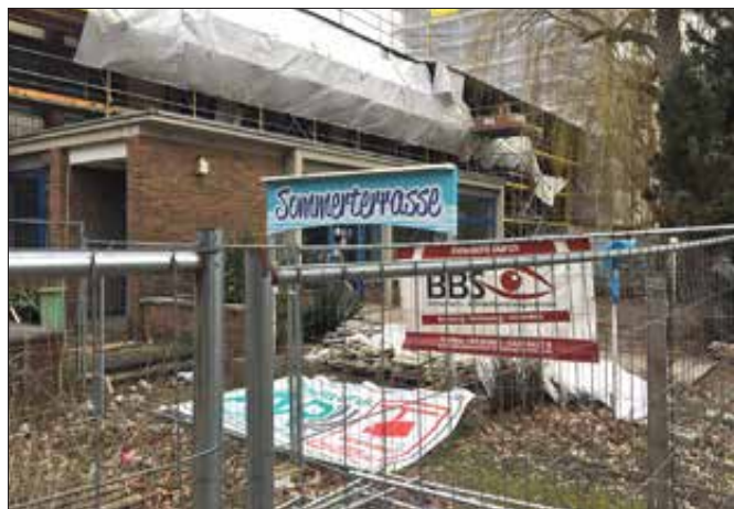
Noch prägen Bauzäune das Bild an der Sommerterrasse des Paracelsus-Bades. Hier soll ein 25-Meter-Außenbecken entstehen. Foto: bek
