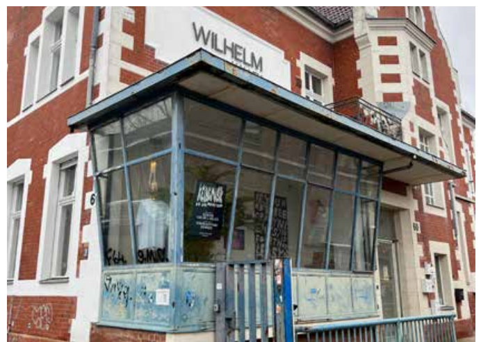
Das Pförtnerhäuschen ist in den 1950er Jahren hinzugekommen.
