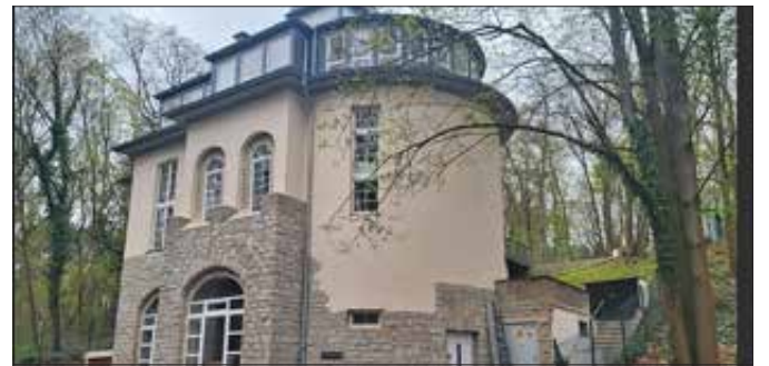
Restaurierter Trafo mit dem Transformator rechts am Haus
