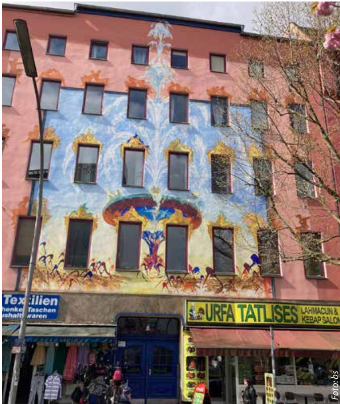
In der Badstraße 65 befand sich das Atelier von Otto Nagel.
