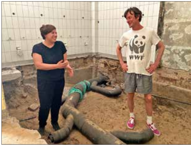
Jelena Surdilovic und Thoms Fuchs (l.) in dem noch nicht fertiggestellten Toilettenhaus Foto: bs
