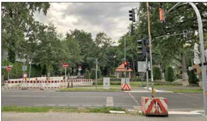
Edelhofdamm, Ampel, Kaiserpavillon, Baustelle links, fertige Fahrradstraße rechts Foto: kbm
