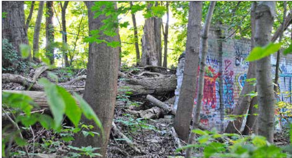
Die gefällten Bäume waren stärker: Sie durchbrachen im Mai die alte Mauer.
