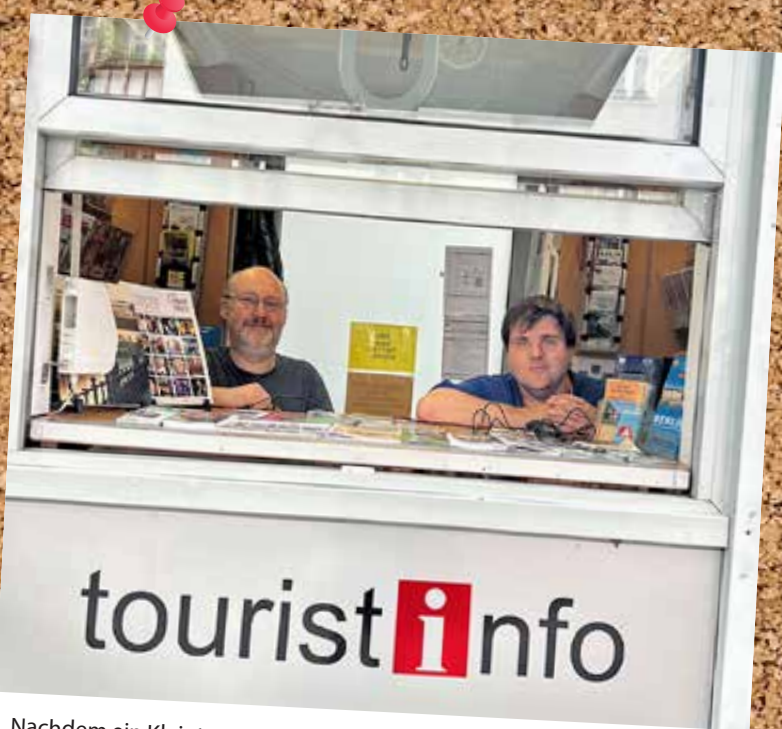
Nachdem ein Kleintransporter die Tourist-Info in Alt-Tegel am 17. Februar beschädigt hatte, war das kleine Gebäude aufgrund von Reparaturmaßnahmen für einige Monate geschlossen. Nun ist der Info-Point wieder offen, und die Mitarbeiter halten eine Vielzahl von Informationsmaterial über den Fuchsbezirk bereit. Foto: Flechtner
