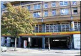
Das Haus mit der Tankstelle wird umgebaut. Foto: dh
