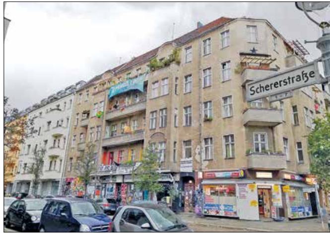
Das Haus in der Schererstraße 8 noch vor der Dachsanierung. Im Moment ist es komplett eingerüstet. Foto: dh
