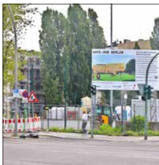
Bauarbeiten auf dem Fußballplatz Safe-Hub Foto: as
