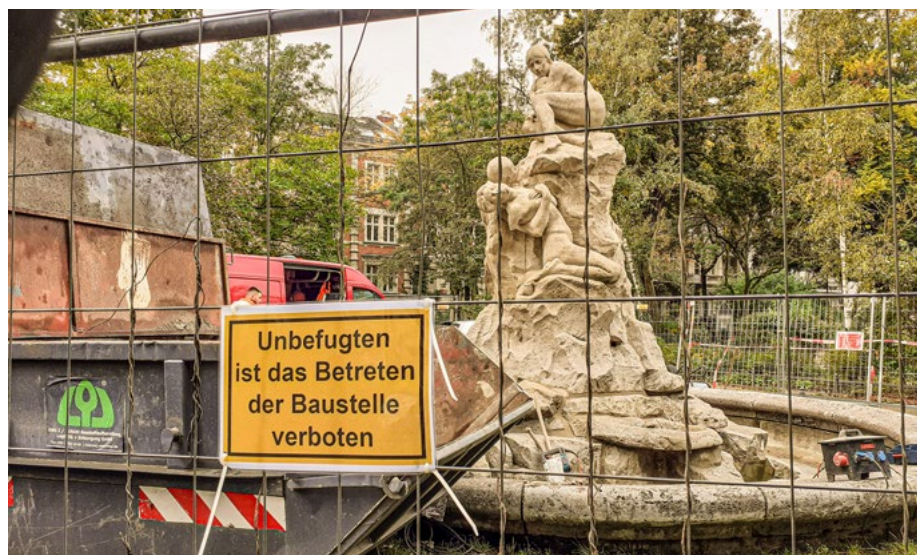
Brunnen mit Bauzaun: Dieses Bild entstand Ende Oktober.
