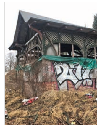
Die Remise wird saniert.
