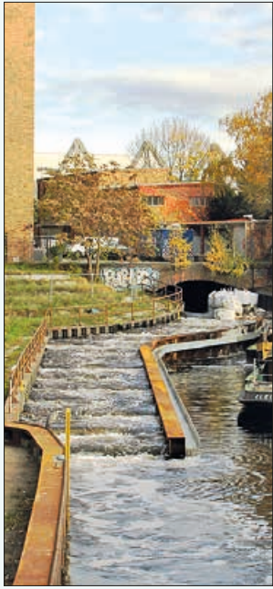
Die neue Fischtreppe am Nordhafenbecken ist noch nicht ganz fertiggestellt, aber bereits in Betrieb.
