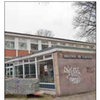
Die Bibliothek am Schäfersee wird saniert. Foto: cs
