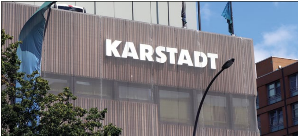
Das Karstadt-Gebäude am Leopoldplatz steht derzeit leer.
