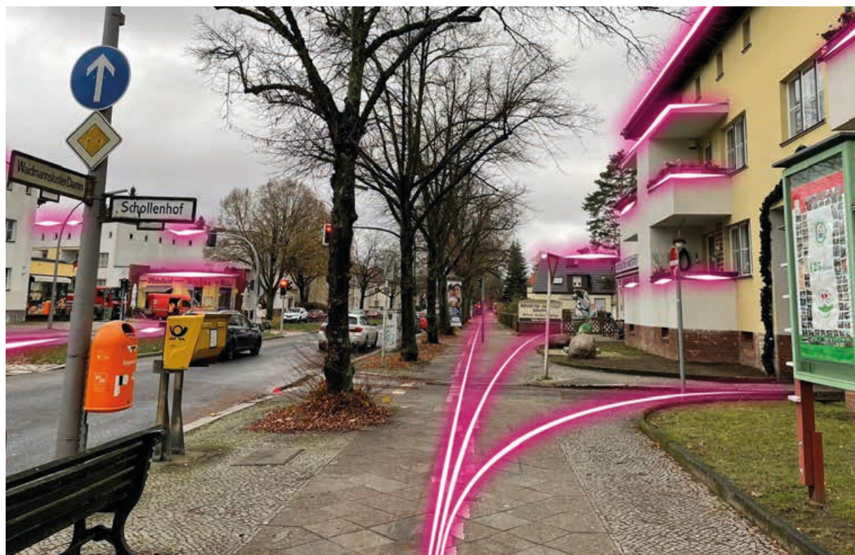
Für rund 48.000 Haushalte im Bezirk Reinickendorf baut die Telekom die Glasfaserleitungen aus.
