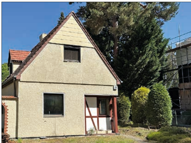
Das Abrisshaus der Familie Angersbach in Frohnau
