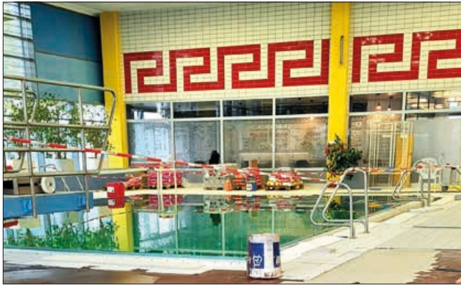
Im Stadtbad Märkisches Viertel der Berliner Bäder Betriebe am Wilhelmsruher Damm wird immer noch gebaut. Foto: Crawford
