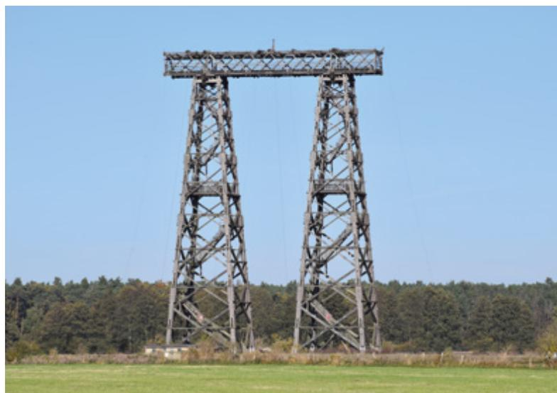
Das Wahrzeichen von Brück: Mit den Holztürmen wurde die Leistung von Funkantennen gemessen, und da Funkwellen von Metall stark beeinflusst werden, durfte ebensolches nicht verbaut werden
