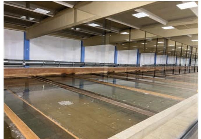
In den Doppelschnellfilterbecken des Wasserwerks Tegel werden Eisen und Mangan herausgefiltert. Foto: fle
