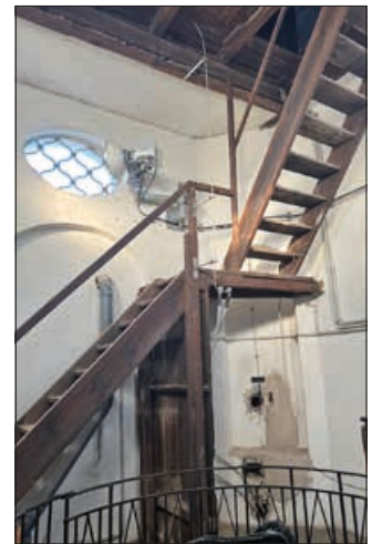
Diese Treppe führt zur Turmspitze.
