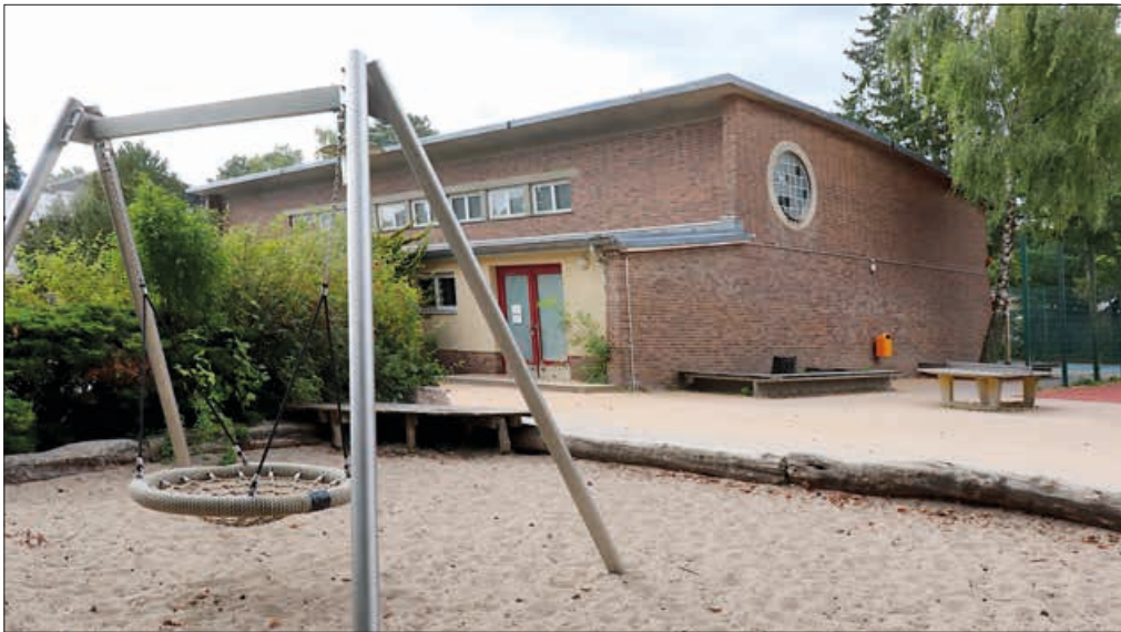
Die Sanitäranlage in der Sporthalle der Renée-Sintenis-Grundschule ist nicht benutzbar.
