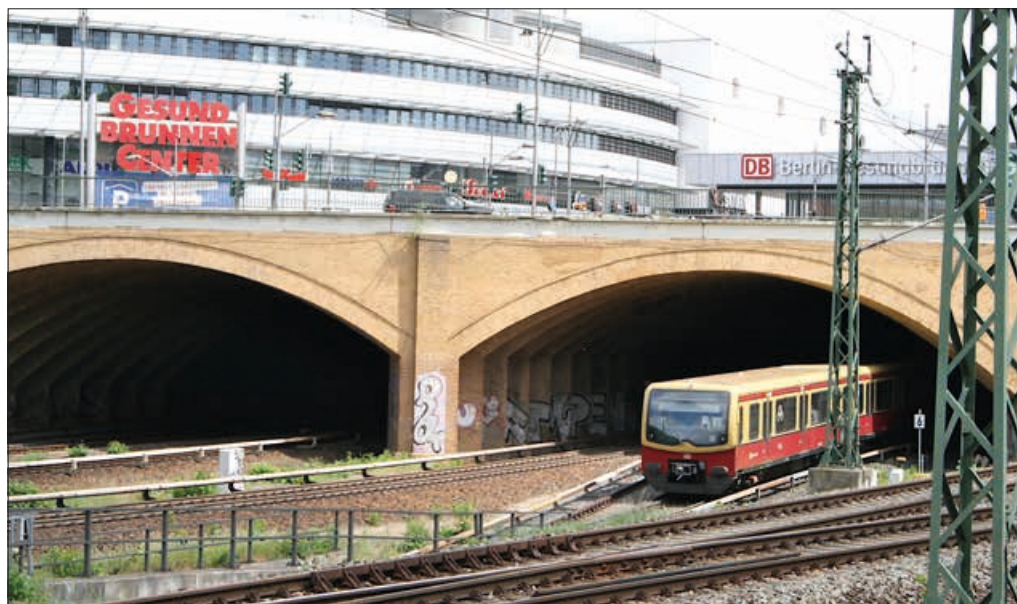
Die Badstraßenbrücke wird saniert, in zwei Jahren soll es losgehen.
