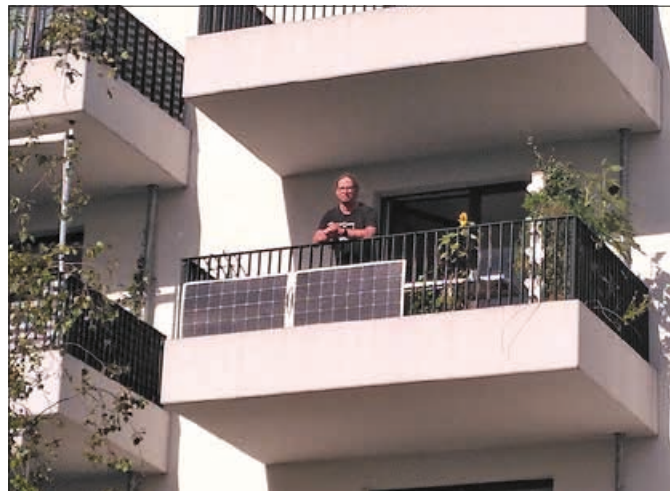
Solaranlage auf dem Balkon in einer Wohnanlage der Gewobag in der Neptunstraße.
