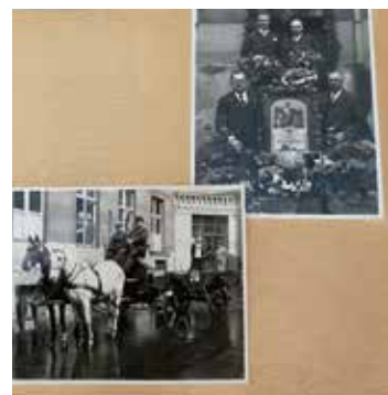
Blick in die Vergangenheit bei Horn – Isolierungen. Fotos: Elke Sarkandy
