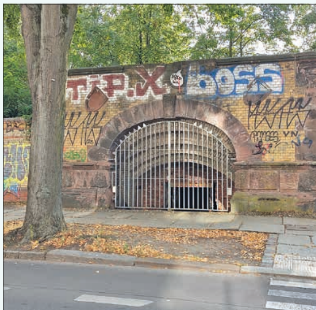
Der Eingang zum Stettiner Tunnel befindet sich in der Gartenstraße. Foto: dh
