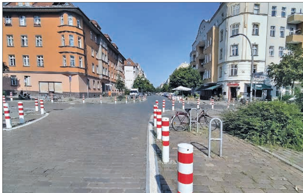
Eine umgebaute Kreuzung in der Genter Straße
