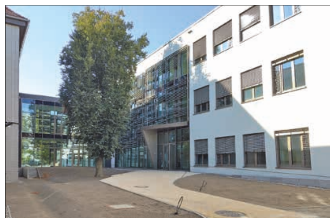
Feierlich eingeweiht und fast fertig: das neue Bettenhaus am Jüdischen Krankenhaus in der Iranischen Straße.
