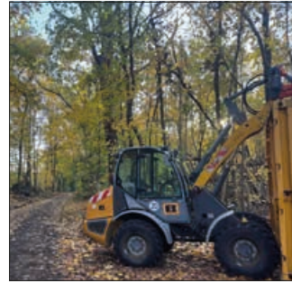
Die Bauarbeiten am Mauerweg unweit der Ruppiner Chaussee haben begonnen. Foto: fle
